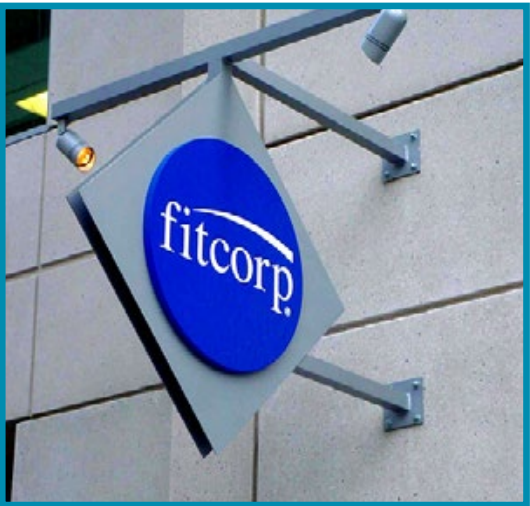
Integrated lighting with hidden conduit Iluminación integrada con conductos eléctrico oculto
