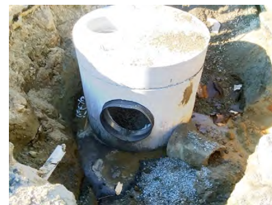
Instalação de bueiro de drenagem.
