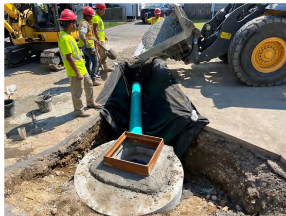
Instalação de bueiro de drenagem.
