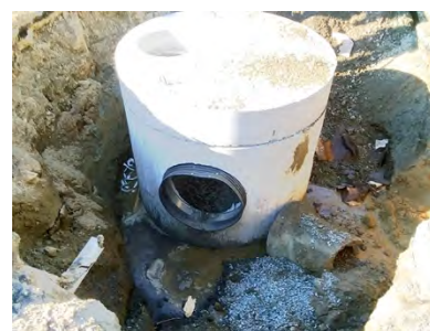
Instalación de arquetas de drenaje.
