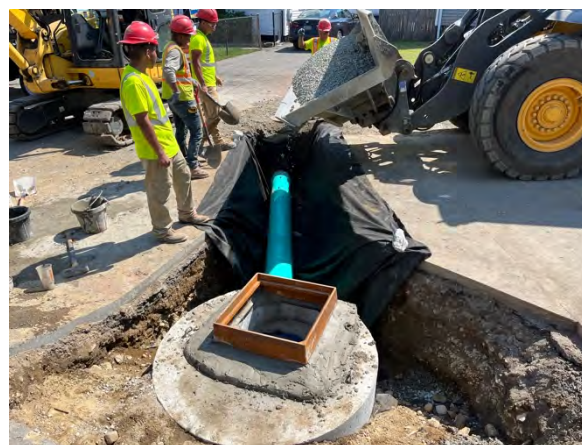
Instalación de arquetas de drenaje.
