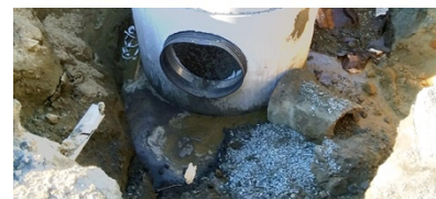
Exemplo de bueiro de drenagem que será instalado.
