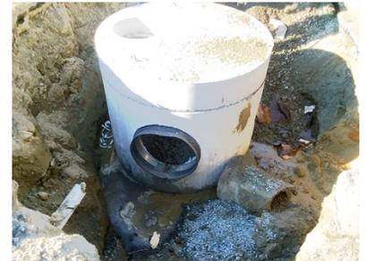
将要安装的排水检修孔示例
