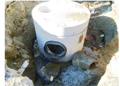
Ejemplo de pozo de drenaje que se instalará.
