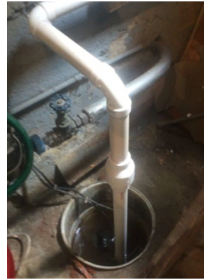
Bomba de sumidero (arriba), Líder de techo (arriba a la derecha), Drenaje del techo (derecha)
